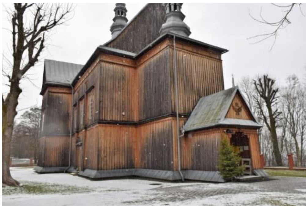
Fot.2. Krzeszów, Kościół Narodzenie NMP. Widok od strony północno-zachodniej. Widoczne zaczerwione obszary na elewacjach obiektu. Stan przed konserwacją. Fot. I. Widlińska, 2022.
