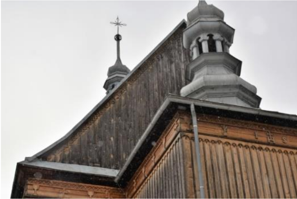
Fot. 3. Krzeszów, Kościół Narodzenie NMP. Widok od strony zachodniej. Widok na szczyt kościoła, gdzie szalunek nie podlegał wymianie w 2006 roku. Stan przed konserwacją. Fot. I. Widlińska, 2022.
