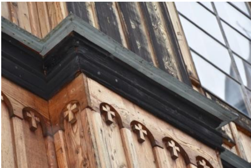
Fot. 7. Krzeszów, Kościół Narodzenie NMP. Widok od strony południowej. Fragment elewacji. Widok na gzyms kordonowy, prawdopodobny pierwotny element drewniany. Stan przed konserwacją. Fot. I. Widlińska, 2022.
