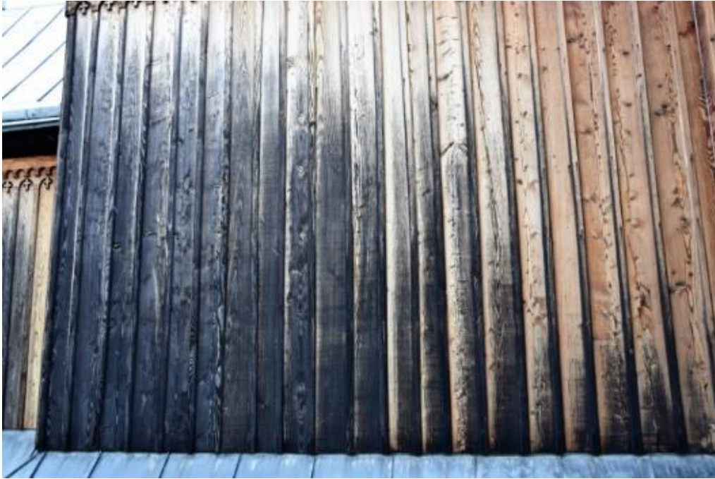
Fot. 10. Krzeszów, Kościół Narodzenie NMP. Widok od strony południowej. Fragment elewacji. Widoczny obszar zacernionego szalunku. Stan przed konserwacją. Fot. I. Widlińska, 2022.
